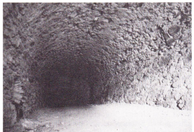
Die Kasematte vor dem Kleinen Ravelin. Sie könnte in einen Rundweg durch das Festungsgelände einbezogen werden.
