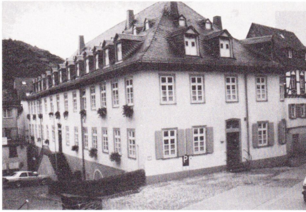
Das reformierte Schulhaus, heute Finanzamt von St. Goar. Mit einem einheitlichen Putz, der zum Baudenkmal gehört, werden drei Häuser in ihrer äußeren Erscheinung zusammengefaßt.
