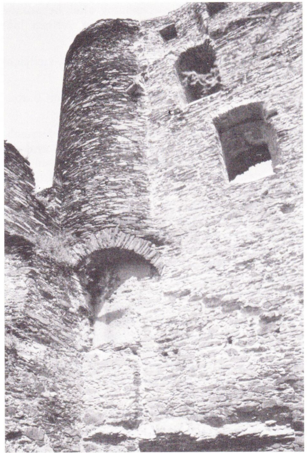
Zweigeschossiger Runderker an der Nordwestecke der inneren Ringmauer. Seine Mauern ruhen auf Bögen, ein Hinweis darauf, daß der Erker im Zusammenhang mit einer späteren Erhöhung der Mauer von dieser Höhe an gebaut wurde.
